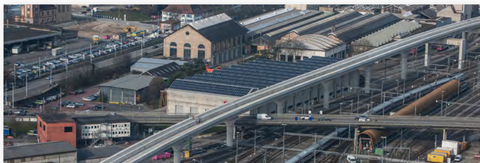
Die neue Letzigrabenbrücke (© SBB)
